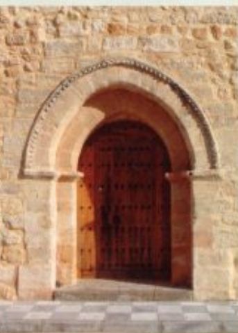
Portada de la Iglesia de Zarzuela de estilo en transición del románico al gótico, el resto más antiguo que recuerda su origen medieval. Una importante remodelación a mediados del siglo XVIII desfiguró su imagen primitiva, elevando la nave y modificando el ábside primitivo, que debió ser semicircular, sustituyéndolo por otro poligonal
